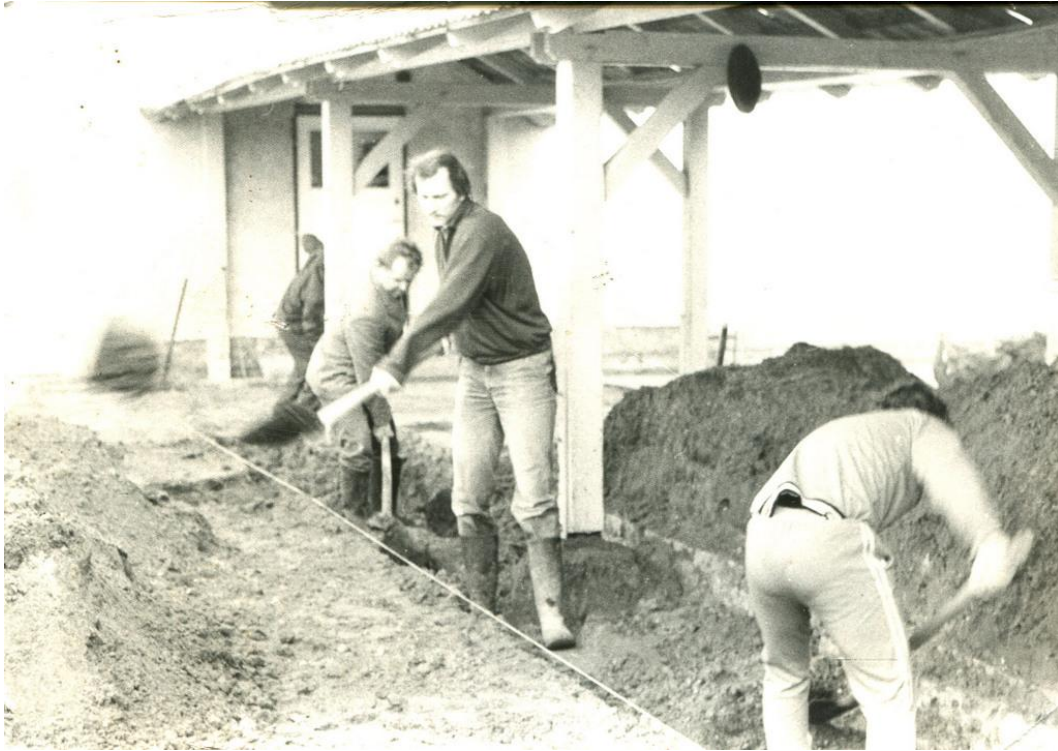
21. ábra: A szaktantermek alapozása
