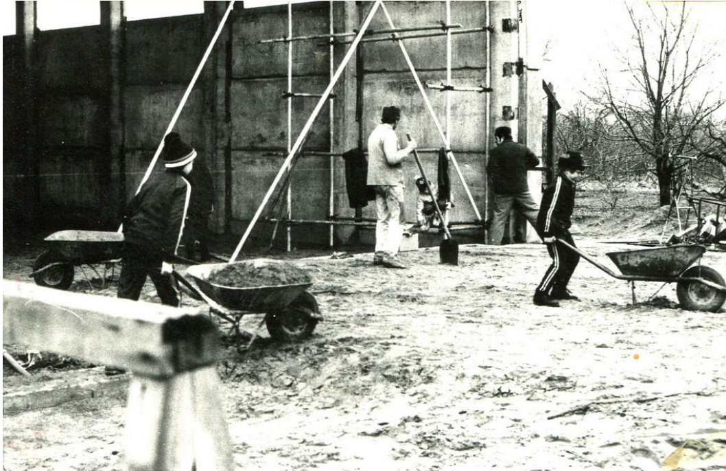
20. ábra: Tornaterem építése
